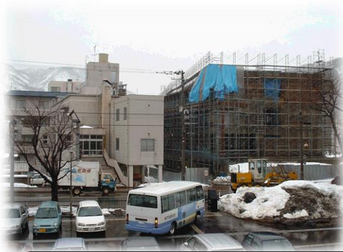
平成 13 年 冬 建設中の医療センター
