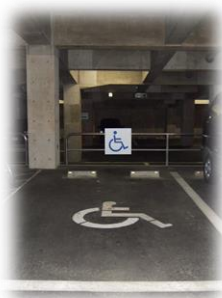
地下 駐車場①
